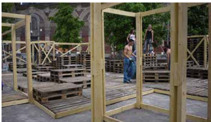
chantier UMLU_Unité Mobiles de Loisirs Urbains Pile au Rendez-Vous 2013
